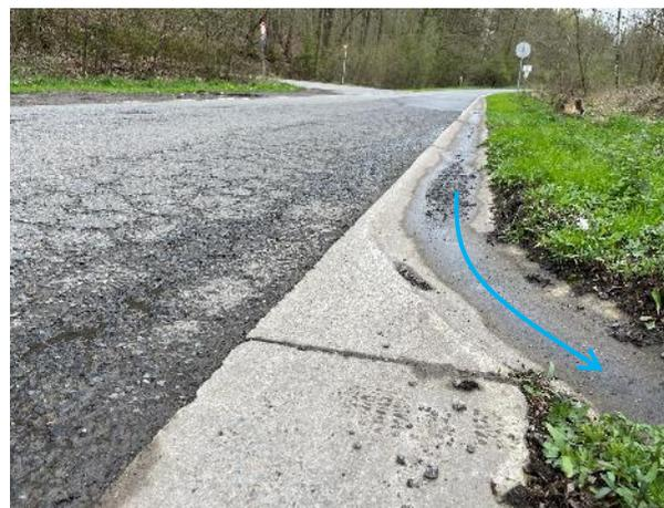
Protection du bord de route par bordure et filet d'eau (pour stabiliser le bord du tablier et éviter l'érosion latérale)
