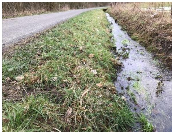
Ouverture de l'accotement pour évacuer l'eau de la voirie vers le fossé adjacent préalablement entretenu (l'ouverture est une simple rigole ou un aménagement bétonné)
