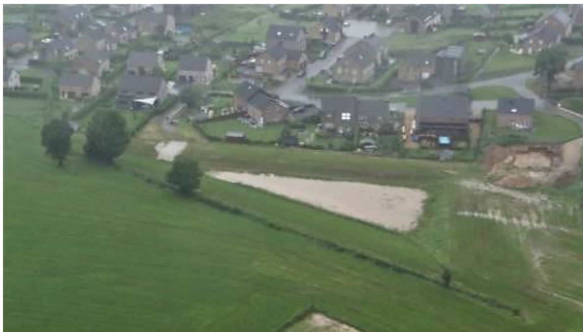
Zone d'immersion temporaire en fonctionnement, située en amont d'un village, situation en juin 2018 après un orage (conception SPW-DAFoR)
