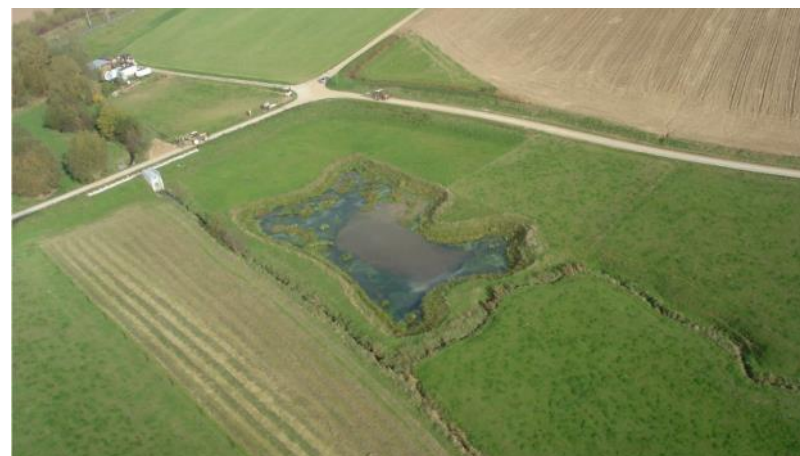
Zone d'expansion de crue, avec mare permanente, conçue pour intercepter et temporiser du ruissellement naturel avant un village.
