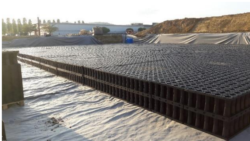
Bassin de rétention souterrain (en cours de construction), destiné à temporiser des eaux issues de l'imperméabilisation dans une zone urbanisée.
