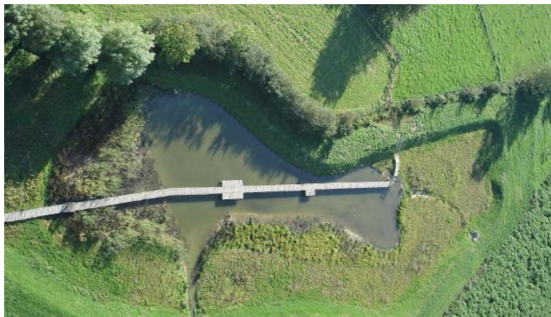
Mare-tampon à deux niveaux (ici, état à vide), conçue pour intercepter et temporiser du ruissellement naturel avant un village.
