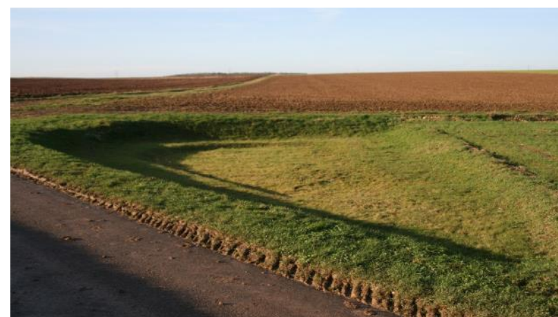
Bassin de rétention enherbé, placé en zone agricole pour temporiser du ruissellement naturel.
