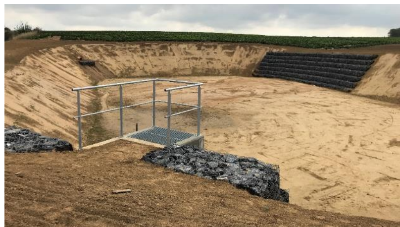
Bassin de rétention en terre, destiné à intercepter du ruissellement agricole avant un village.
