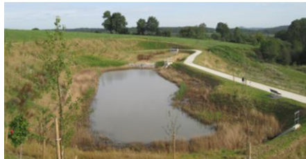
Figure 17 : Bassin d'orage dans le zoning de Damré (Sprimont), SGS Belgium, 2012
