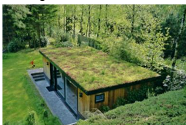
Figure 13 : Toiture végétale (Source : biodiversite.wallonie.be)
