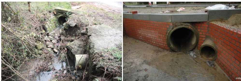
Figure 19 : Réparation d'ouvrages d'art dégradés sur le ruisseau de Gobertange à Jodoigne (photo avant – après) (source : Contrat de rivière Dyle-Gette asbl)
