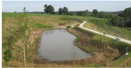
Figure 18 : Bassin d'orage dans le zoning de Damré (Sprimont), SGS Belgium, 2012
