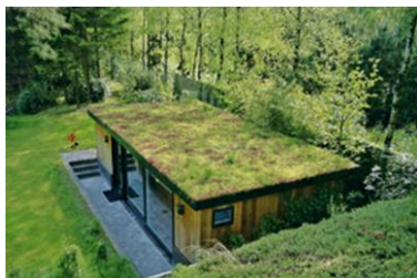
Abbildung 15 : Grünes Dach (Quelle : biodiversite.wallonie.be)
