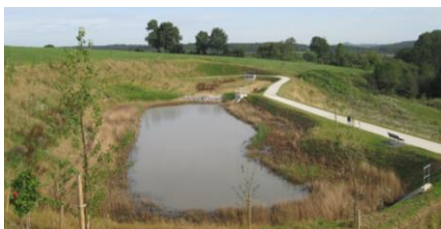
Abbildung 19 : Regenüberlaufbecken in Gewerbegebiet Damré (Sprimont), SGS Belgium, 2012
