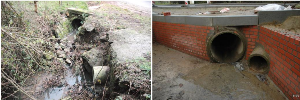
Abbildung 20 : Instandsetzung von beschädigten Werken am Bach Gobertange in Jodoigne (Photo vorher – nachher) (Quelle : Contrat de rivière Dyle-Gette asbl)
