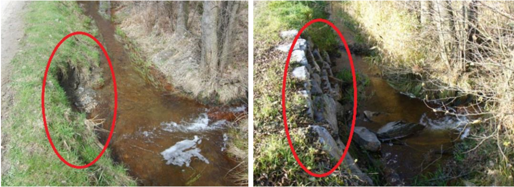
Afbeelding 29: Oeverbescherming van de beek Barechin (Provincie Luxemburg) waarvan de erosie een weg bedreigde (foto voor en na) (Bron: Riviercontract Amel asbl/vzw)
