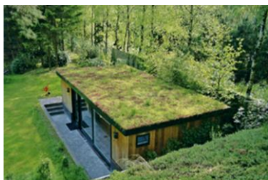
Figure 17 : Toiture végétale (Source : biodiversite.wallonie.be)
