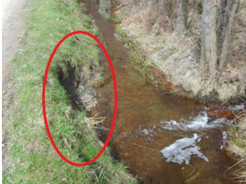
Figure 29 : Protection de la berge du ruisseau de Barechin (Province du Luxembourg) dont l'érosion menaçait un chemin (photo avant – après) (source : Contrat de rivière pour l'Amblève asbl)
