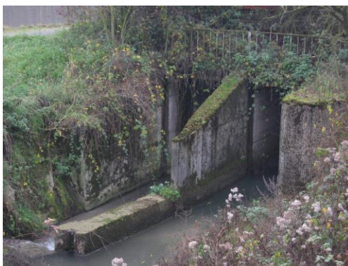
Figure 26 : Pertuis sur le ruisseau du Piéton à Courcelles (source : SGS Belgium, novembre 2010)
