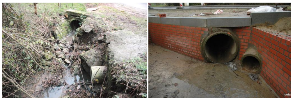
Figure 28 : Réparation d'ouvrages d'art dégradés sur le ruisseau de Gobertange à Jodoigne (photo avant – après) (source : Contrat de rivière Dyle-Gette asbl)
