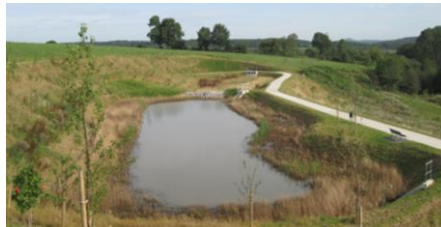
Abbildung 25 : Regenüberlaufbecken in Gewerbegebiet Damré (Sprimont), SGS Belgium, 2012
