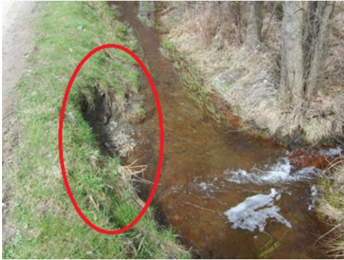
Abbildung 29: Schutz des Ufers des Baches von Barechin (Provinz Luxemburg), durch dessen Erosion ein Weg gefährdet war (Foto vorher – nachher) (Quelle: Flussvertrag Amel GoE)
