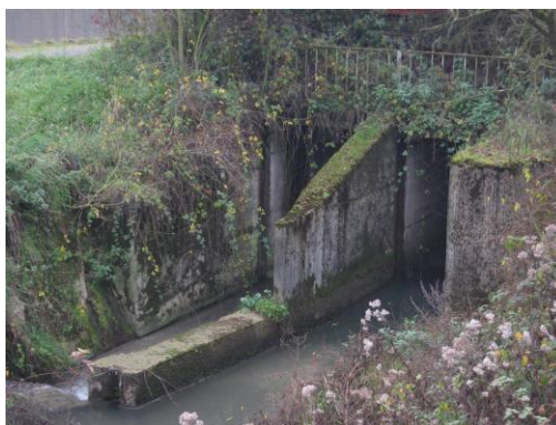
Abbildung 26 : Wasserdurchlass am Bach Piéton in Courcelles (Quelle : SGS Belgium, November 2010)
