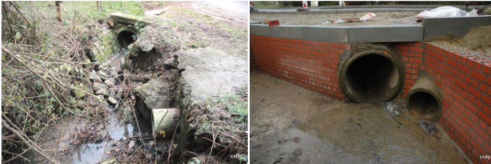
Abbildung 28 : Instandsetzung von beschädigten Werken am Bach Gobertange in Jodoigne (Photo vorher – nachher) (Quelle : Contrat de rivière Dyle-Gette asbl)
