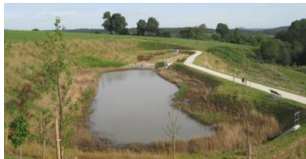
Afbeelding 25: Stormbekken in de industriezone van Damré (Sprimont), SGS Belgium, 2012
