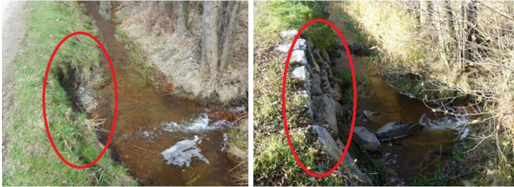
Afbeelding 27: Oeverbescherming van de beek Barechin (Provincie Luxemburg) waarvan de erosie een weg bedreigde (foto voor en na) (Bron: Riviercontract Amel asbl/vzw)
