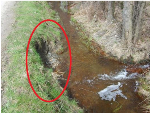
Figure 27 : Protection de la berge du ruisseau de Barechin (Province du Luxembourg) dont l'érosion menaçait un chemin (photo avant – après) (source : Contrat de rivière pour l'Amblève asbl)
