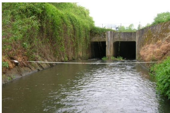
Figure 26 : Pertuis sur la Sennette à Oisquercq (source : SPW 2015)
