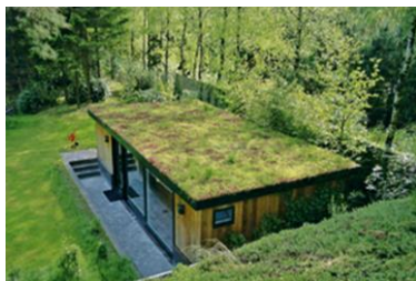
Figure 17 : Toiture végétale (Source : biodiversite.wallonie.be)
