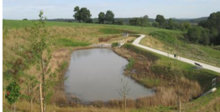
Figure 25 : Bassin d'orage dans le zoning de Damré (Sprimont), SGS Belgium, 2012
