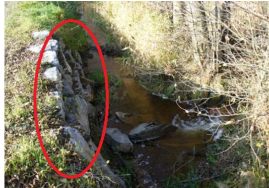
Figure 27 : Protection de la berge du ruisseau de Barechin (Province du Luxembourg) dont l'érosion menaçait un chemin (photo avant – après) (source : Contrat de rivière pour l'Amblève asbl)
