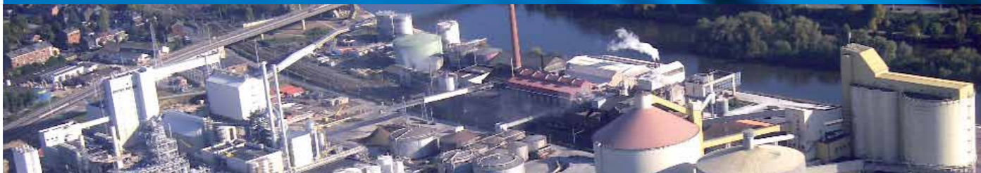
Foto : Luchtstandpunt van de Tiense Raffinaderij - Plaats van Wanze en Biowanze
