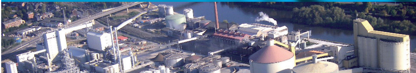
Photo : Vue aérienne de la raffinerie Tirlémontoise - Site de Wanze et Biowanze - Raffinerie Tirlémontoise
