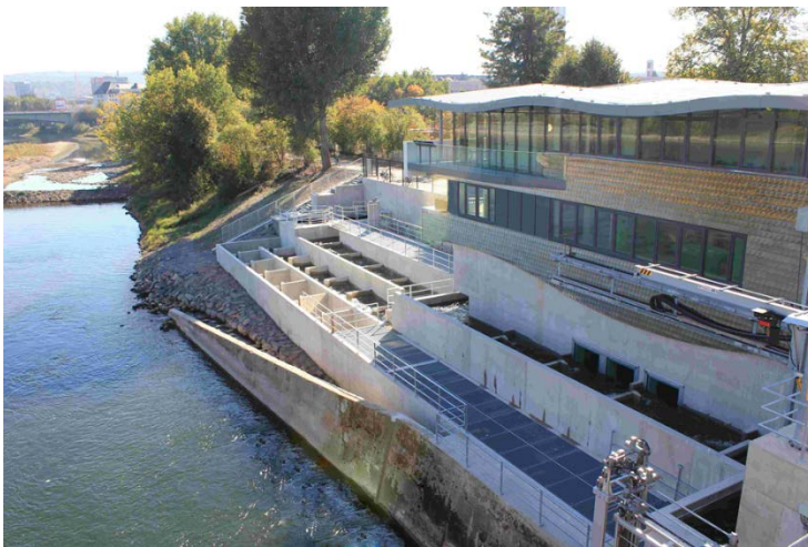
Figure 37 : passe à poissons et centre d'information « Mosellum » sur le barrage le plus aval de la Moselle à Coblenz (photo : Christian von Landwüst)
