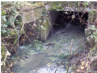
Rebaix - Ruisseau du Robier
