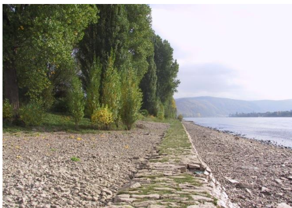
Figuur 25: Rijnoever voor (links) en na (rechts) de hydromorfologische maatregel - overgang van een verharde oever naar een vlakke oever (foto's: Angelika Halbig, BCE; Ernst-Dieter Kuczera, SGD Nord)
