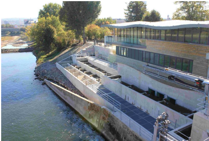
Figuur 23: Vispassage aan de onderste stuw in de Moezel te Koblenz en het bezoekerscentrum "Mosellum" (foto: Christian von Landwüst)
