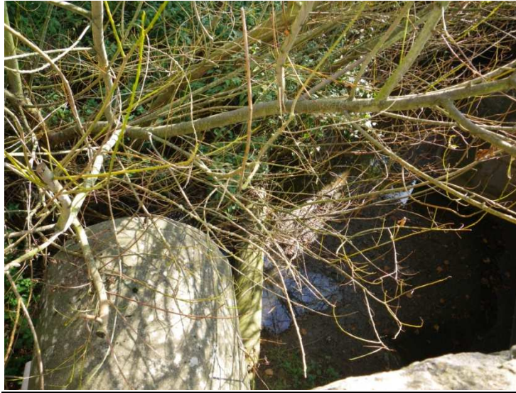
Figure 51: exutoire du DO 2 relevé sur le terrain le 12/10/2010.
