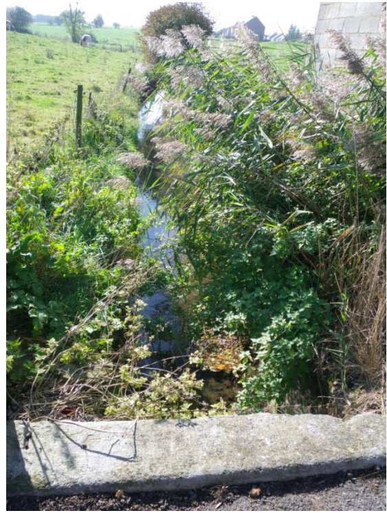
Figure 55 : exutoire des DO 2 et 3 relevés sur le terrain le 12/10/2010.
