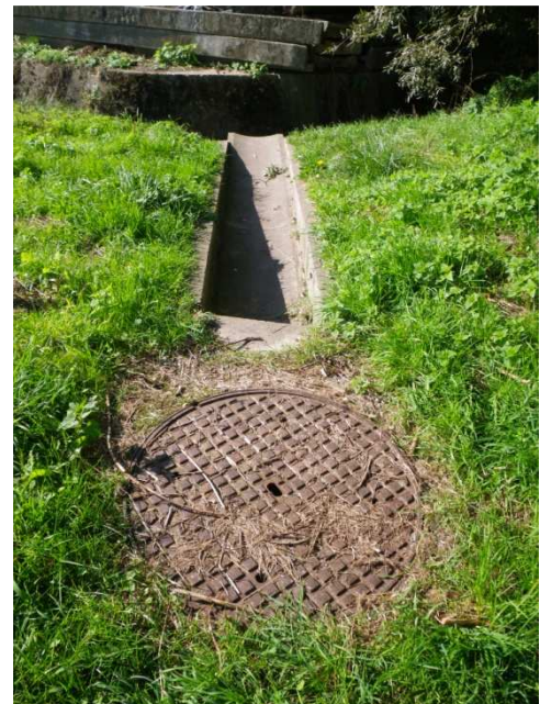
Figure 53 : DO 4 et exutoire relevés sur le terrain le 12/10/2010.
