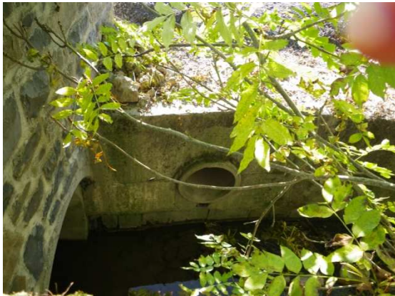
Figure 60 : exutoire DO 14 relevé sur le terrain le 12/10/2010.
