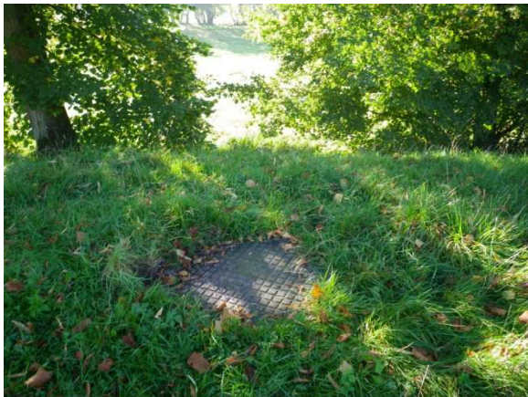
Figure 64 : exutoire DO 18 relevé sur le terrain le 12/10/2010.
