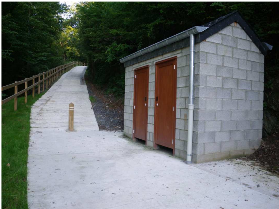
Figure 39: présence de vestiaires dans la zone de baignade H16
