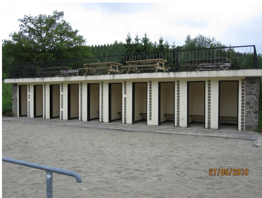
Figure 41 : infrastructures liés à la zone de baignade H03
