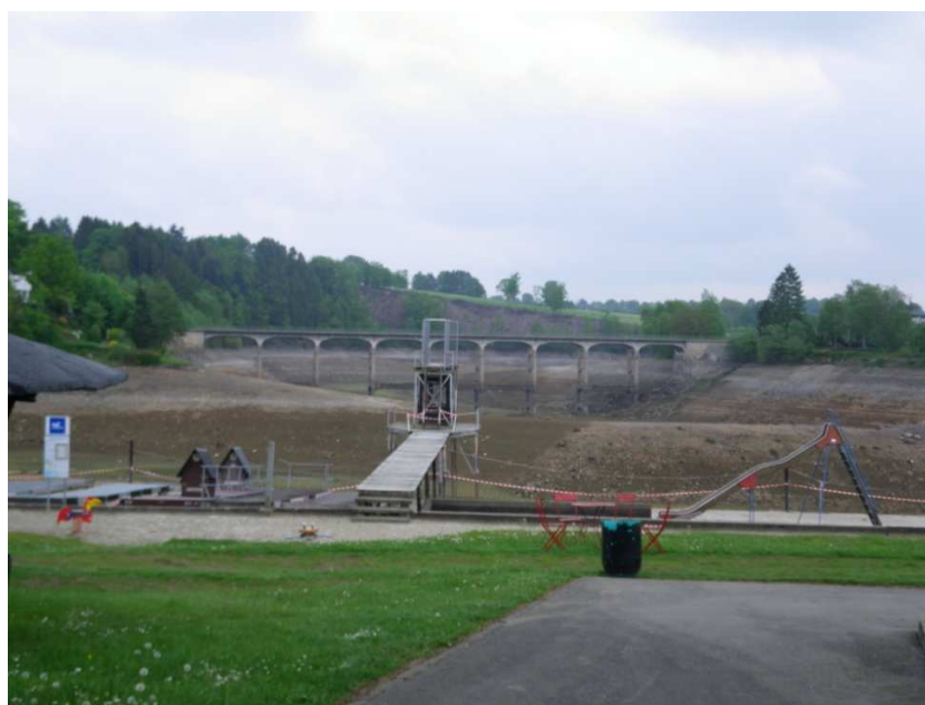
Figure 4: photographie de la zone de baignade du lac de Robertville – F01- (photo prise le 01/06/2010).
