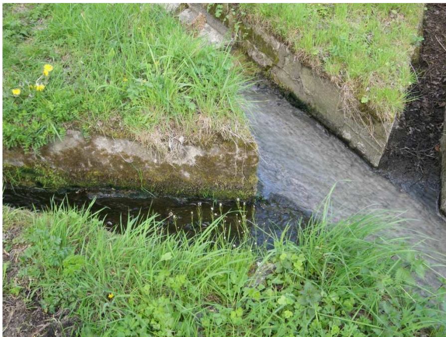
Figure 40: rejet d'eaux usées dans le ruisseau la Commune
