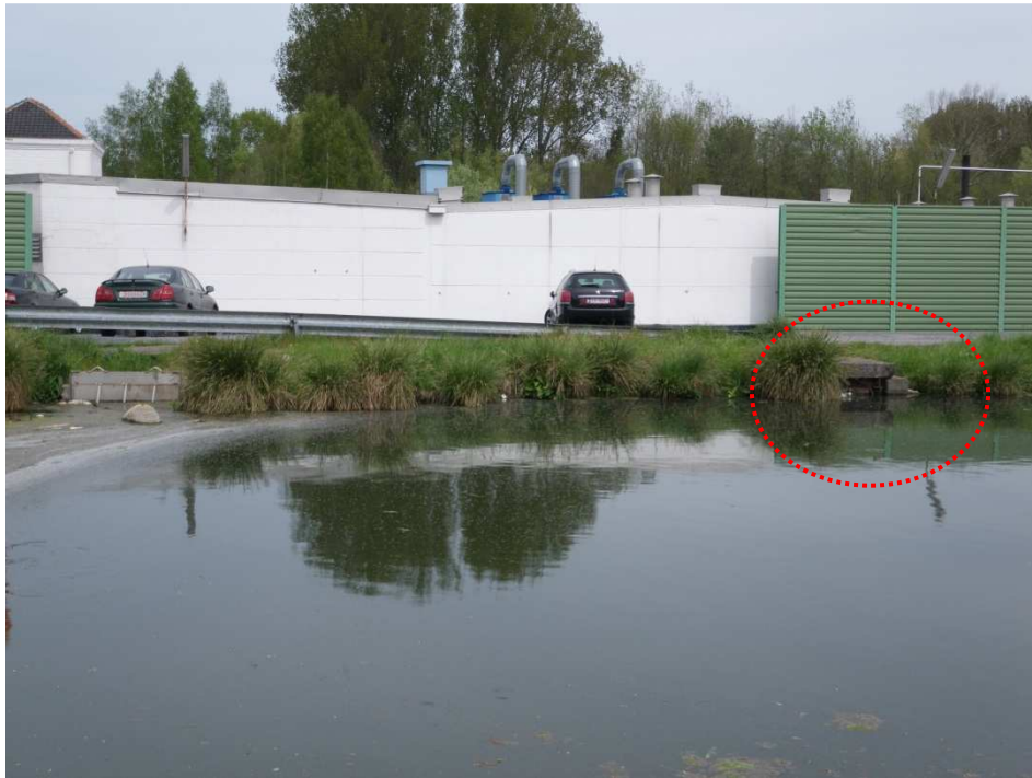
Figure 35 : rejet d'eaux usées provenant de l'usine SALUC, dans l'ancien canal. Photo prise le 29/04/10. Source: PROTECTIS, 2010
