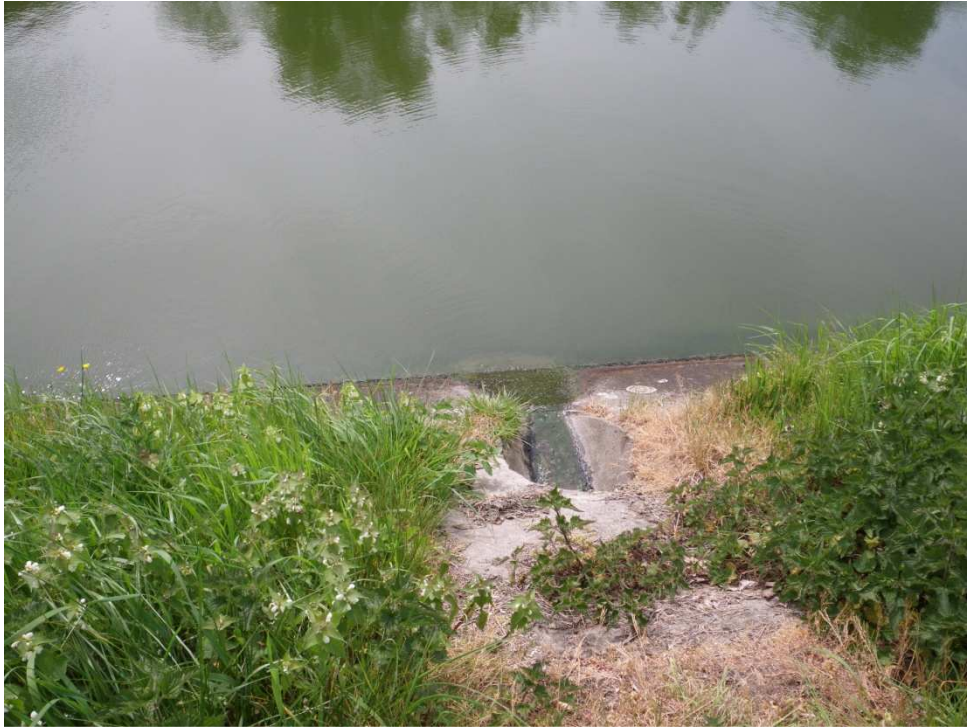
Figure 40: rejet d'eaux usées provenant du village de Calenelle, dans le canal Nimy-Blaton-Péronnes. Photo prise le 29/04/2010.
