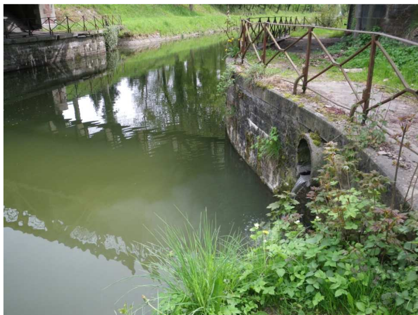
Figure 39: rejet d'eaux usées provenant du village de Maubray, dans l'ancien canal. Photo prise le 29/04/2010.
