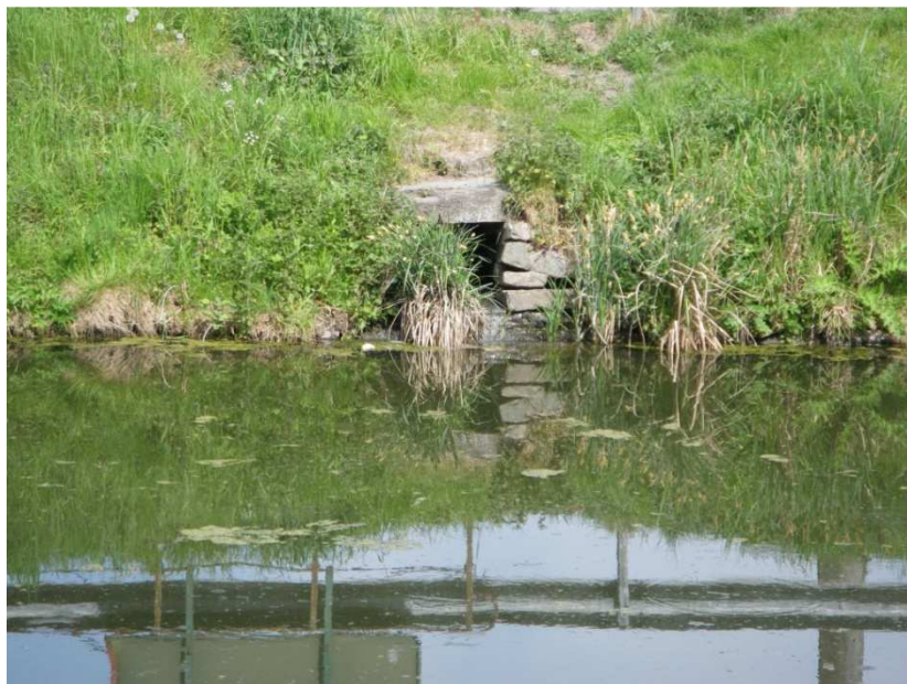
Figure 38: rejet d'eaux usées provenant de la commune de Péronnes, dans l'ancien canal. Photo prise le 29/04/2010.
