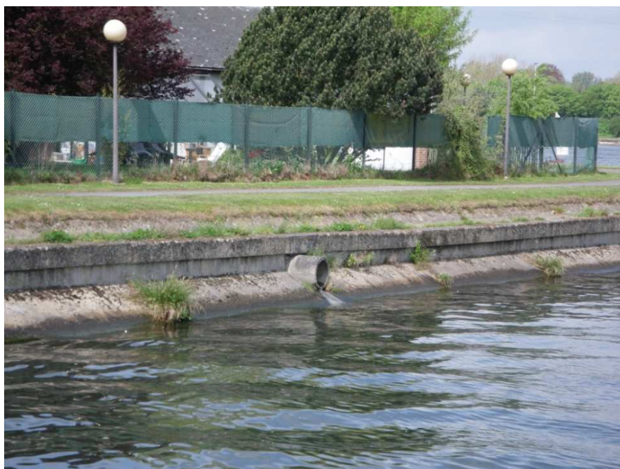
Figure 28: rejet provenant de la STEP de l'ADEPS dans le Grand Large- E03 (photo prise le 30/04/2010). Source: PROTECTIS.
