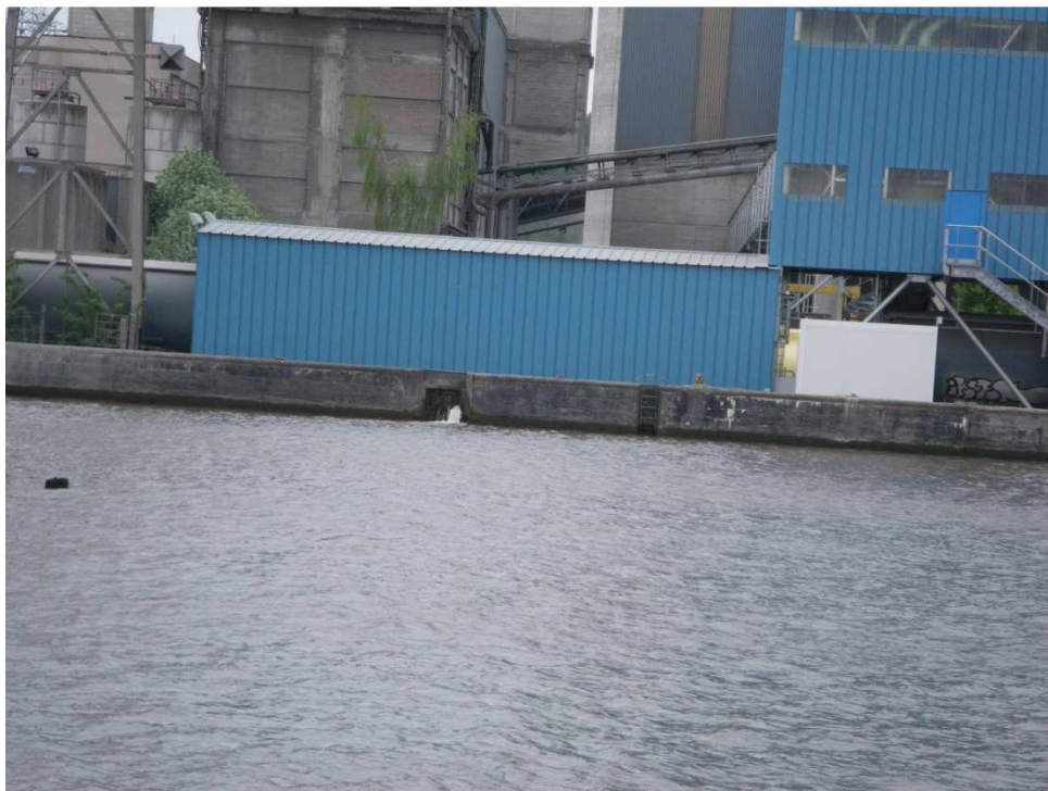
Figure 42: rejet d'eaux usées industrielles dans le canal –partie est de la zone amont de la zone de baignade E03
