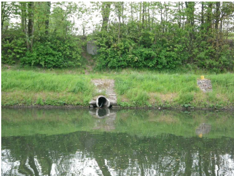
Figure 38: rejet d'eaux usées dans le canal –partie ouest de la zone amont de la zone de baignade E03
