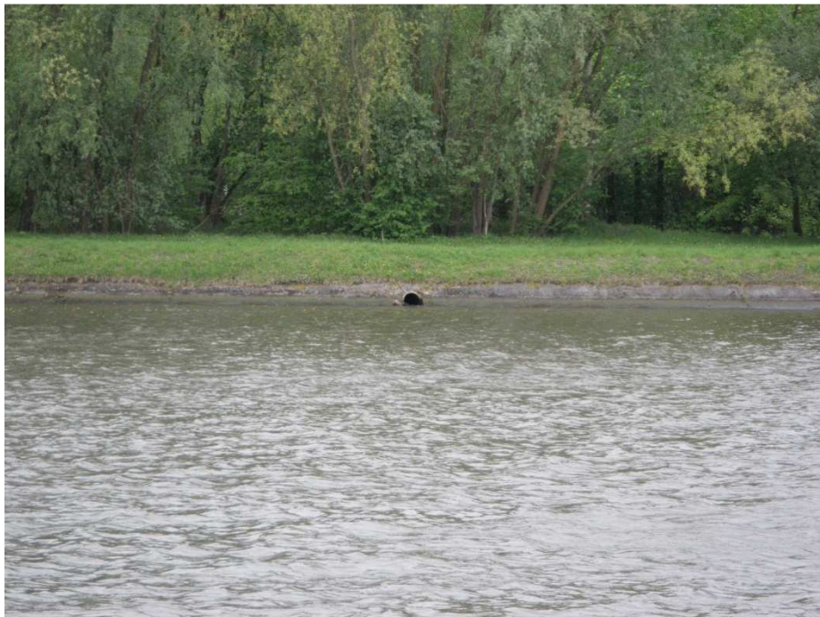
Figure 41: rejet d'eaux usées dans le canal –partie est de la zone amont de la zone de baignade E03
