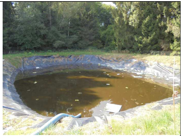
8. Bassin de collecte des percolats
