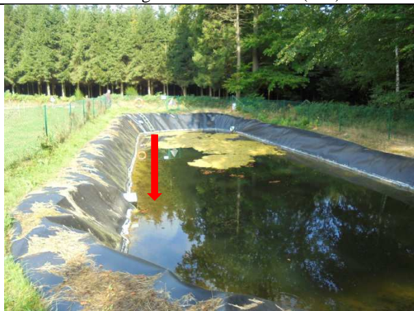
5. Point de prélèvement "Drain Est"
