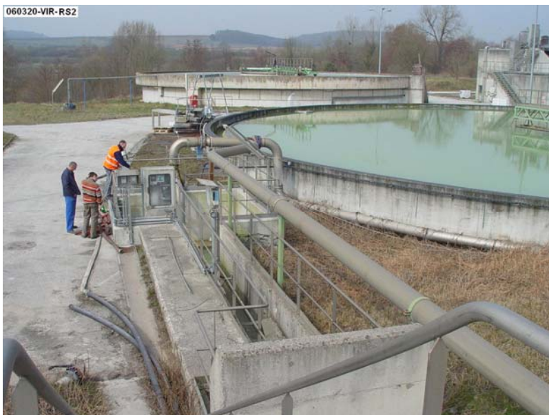
Photos : Prélèvements de rejets STEP à Froidchappelle et à Virton (Burgo Ardennes)
