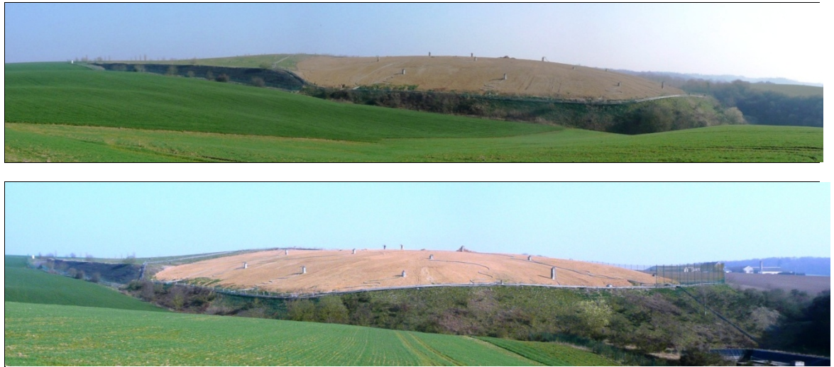
Figure 1 : Panoramiques du site après sa réhabilitation (photos du 28/03/2011)
