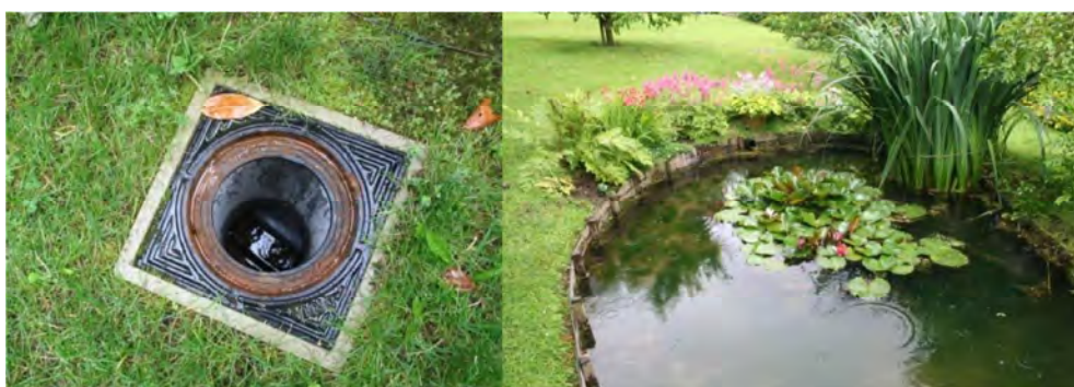
Figure 7 : Chambre de visite du Drain Parent et étang
