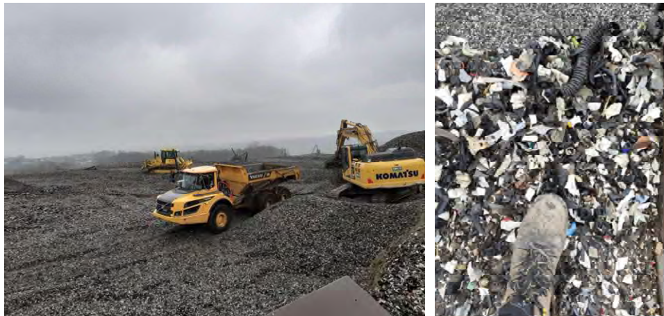
Figure 1 : Vue à partir du sommet (quai de déchargement, vers le nord), rehausse des puits de collecte des gaz et Draina Plus (en bas à droite)
