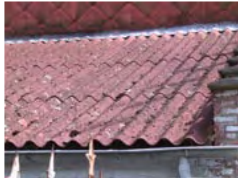
Plaques ondulées de toiture en amiante-ciment
