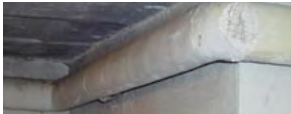
Exemple d'application friable : flocage d'isolation
