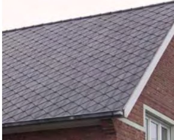
Ardoises en amiante-ciment
