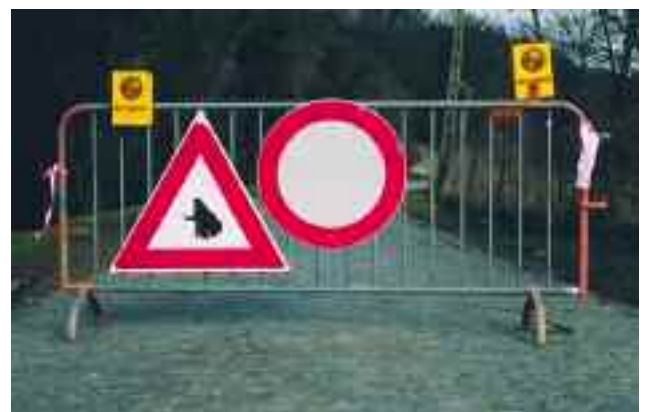
Photo 21. Fermeture d'une route par barrières amovibles ; remarquez les gyrophares.
