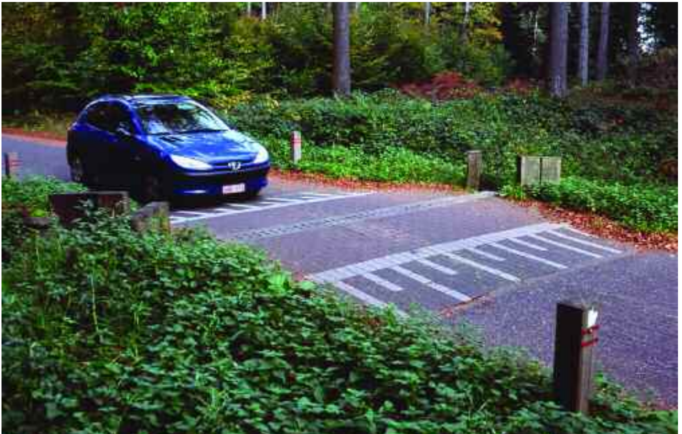
Photo 31. Tunnel à double sens de petit diamètre placé au centre d'un casse-vitesse.
