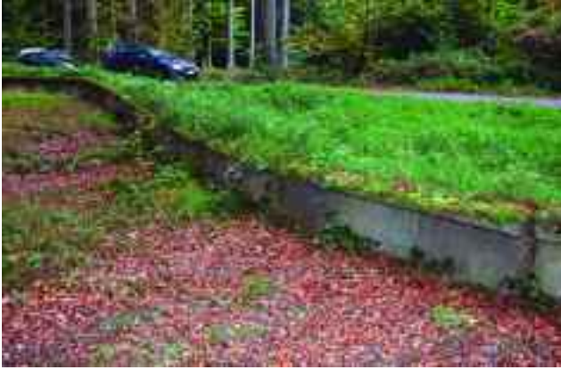
Photo 23. Barrière permanente en béton longeant la route conduisant les batraciens vers un passage souterrain ou un crapauduc - © C. et N. Percsy
