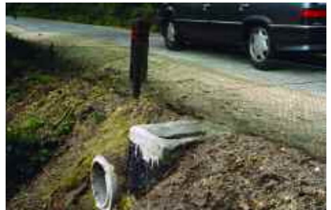
Photo 25. Tunnels à batraciens. Il s'agit d'une paire de tunnels à un sens (voir explications dans la partie technique). Au pied de la barrière se trouve le trou conduisant à l'entrée d'un tunnel. (Notons qu'idéalement les bords de ce trou devraient être partout au niveau du sol.) A sa gauche débouche le second tunnel, servant à la migration en sens inverse - © C. et N. Percsy
