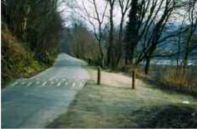
Photo 20. Des casse-vitesse sont installés sur une route secondaire longeant un étang.
