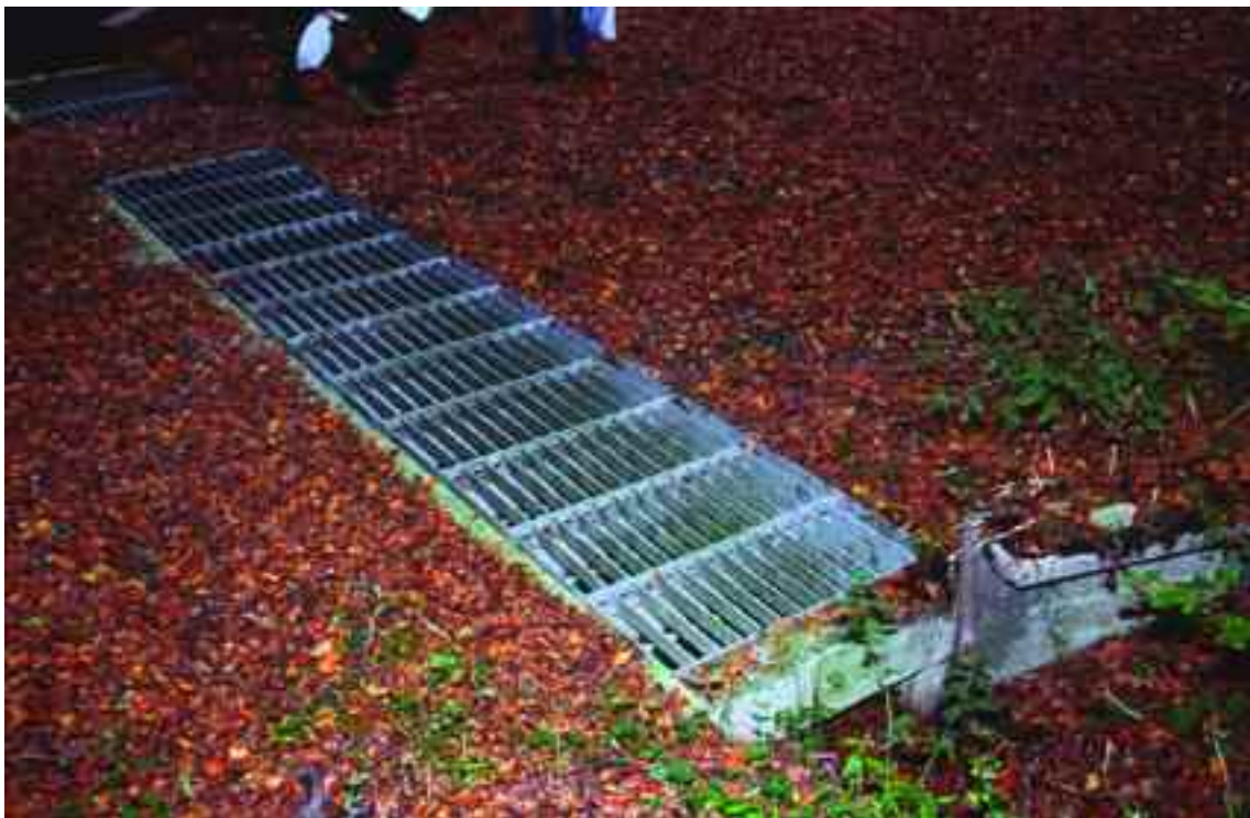
Photo 29. Caniveau de récolte de batraciens au travers d'un chemin latéral : la grille recouvre un canal en U, visible en haut à gauche et en bas à droite, conduisant les animaux vers des passages souterrains. © C. et N. Percsy
