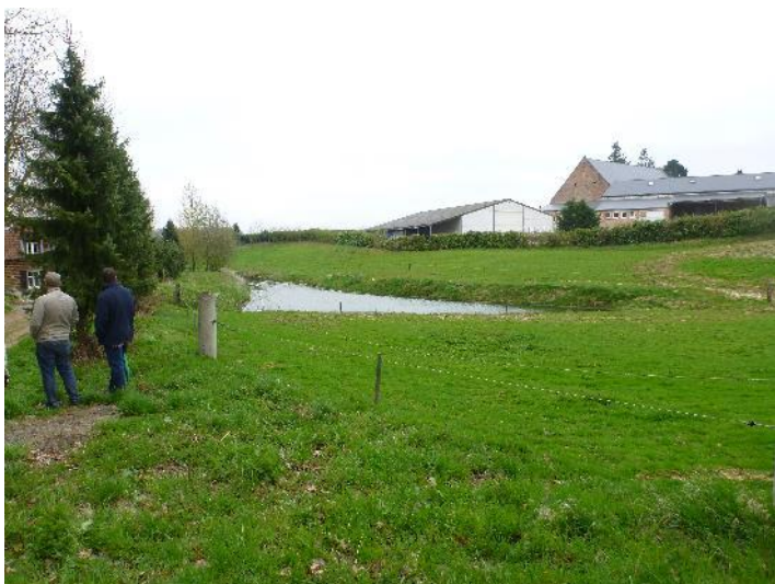
Photo 6 : un volume de rétention s'avère souvent nécessaire pour temporiser les volumes d'eaux pluviales importants générés par les infrastructures agricoles
