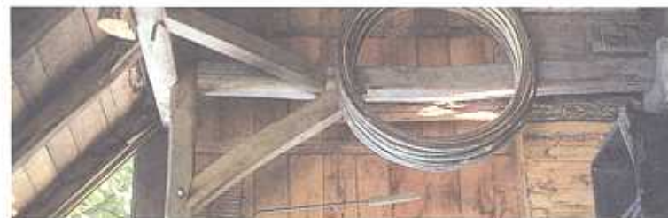
Abri de jardin. La charpente et les bardeaux sont en châtaignier.
