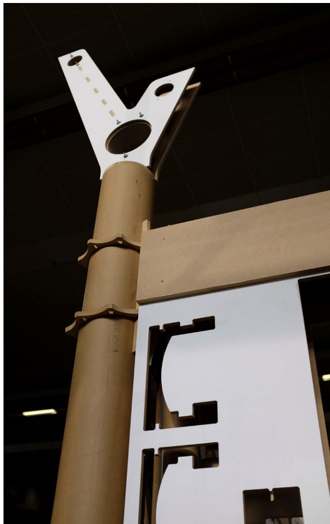
Les bagues de fixation mises en oeuvre, RECUPère.
