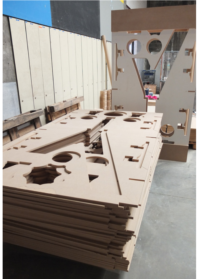
Les chutes des découpes utilisées pour les cloisons et la première cloison montée, RN.
