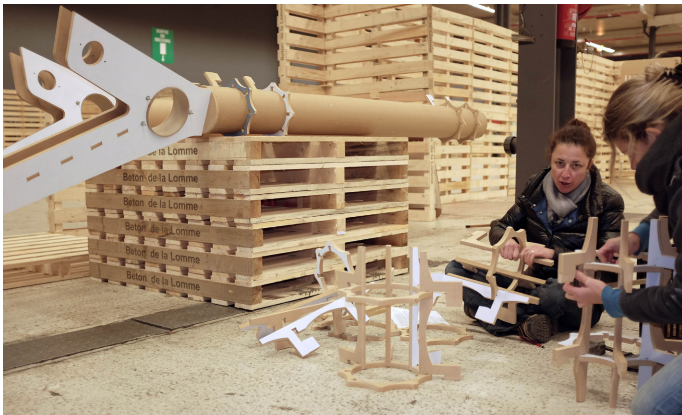
La préfabrication sur site des bagues de fixation avant l'encastrement des poteaux, RECUPère.
