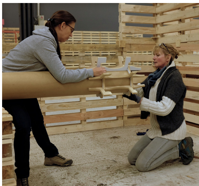
L'enfilage des bagues autour des poteaux.
