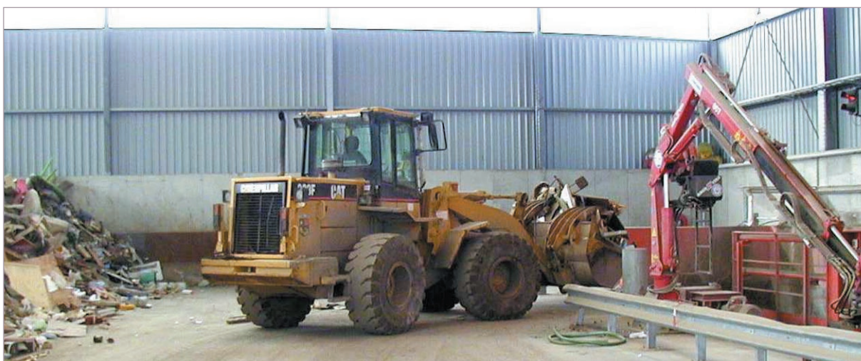
Unité de prétraitement des encombrants.
