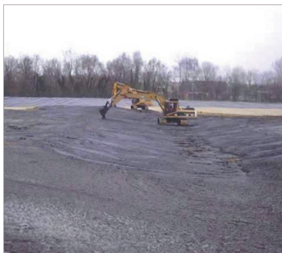
Centre d'Enfouissement Technique de boues de dragage.
