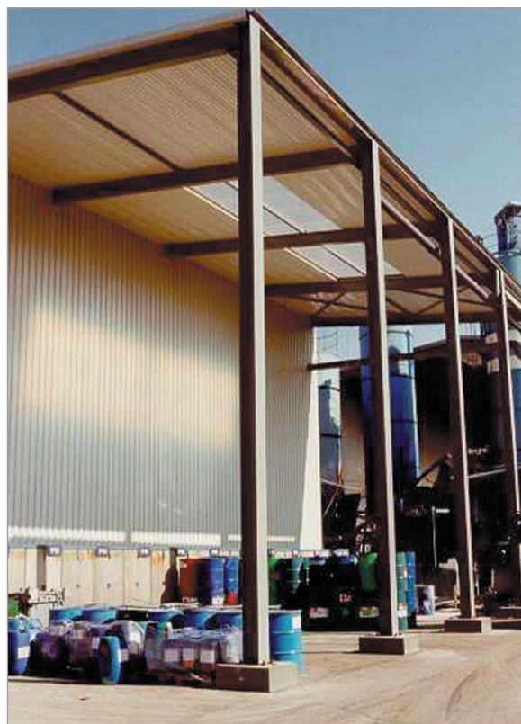
Stockage des déchets dangereux.
