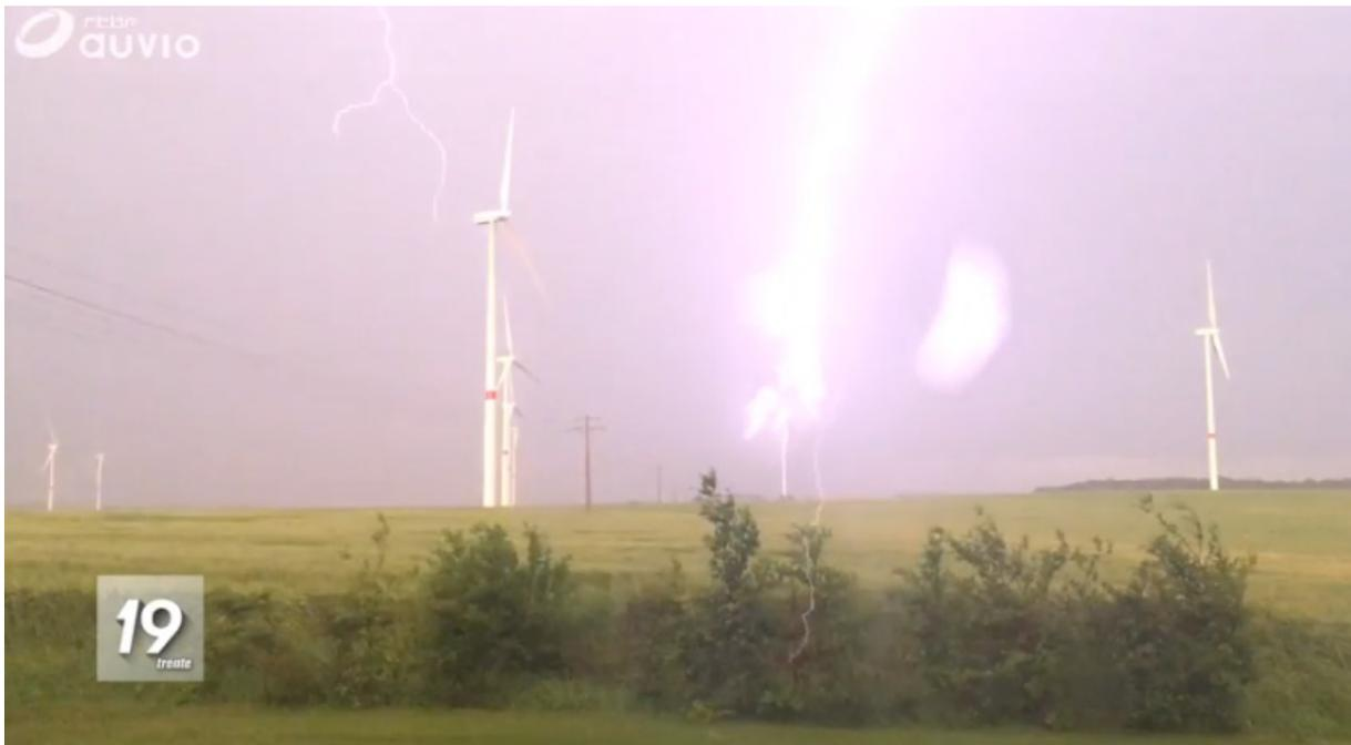
Les éoliennes sont équipées d'un système parafoudre au niveau de chaque pale et de la nacelle, qui dévie les éventuels coups de foudre de manière à éviter tout dégât. Les coups de foudre sont déviés de l'extrémité des pales qui présentent une pointe en aluminium moulé et des bords d'attaque et de fuite équipés de profilés en aluminium reliés à leur base.
