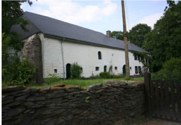
Mur en pierres sèches à Wyompont
