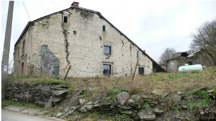
Brisy : un exemple de toiture étalée favorisant de larges pignons. Le faîte est « brisé » par des croupettes
