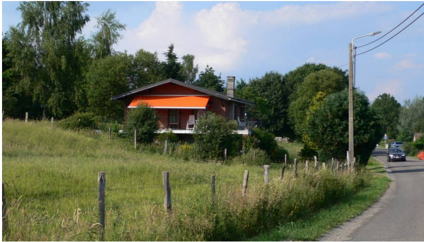
Champs (Bertogne). Habitat exogène de type chalet s'intégrant faiblement au contexte villageois, de par son style architectural et son mode d'implantation « autonome ».
