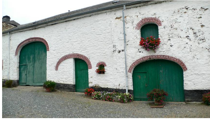
Buisson : usage traditionnel de la brique réservé aux encadrements de baie
