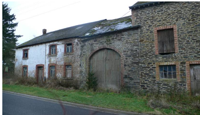
Buret : une ancienne ferme « dans son jus ». Elle permet d'observer un usage de la brique en maçonnerie (à gauche), mais il s'agit d'une brique recouverte d'un badigeon de chaux de teinte blanche !
