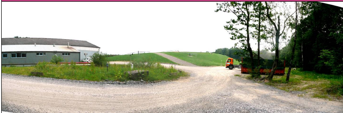
Figure 1 : vue panoramique du C.E.T. réhabilité
