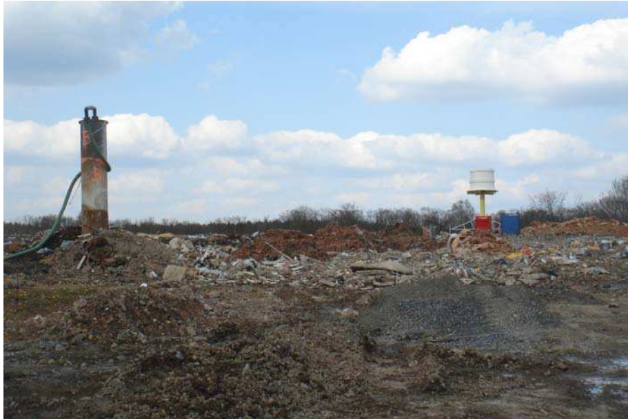
Figure 1 : Dégazement d'un puits de dégazage
