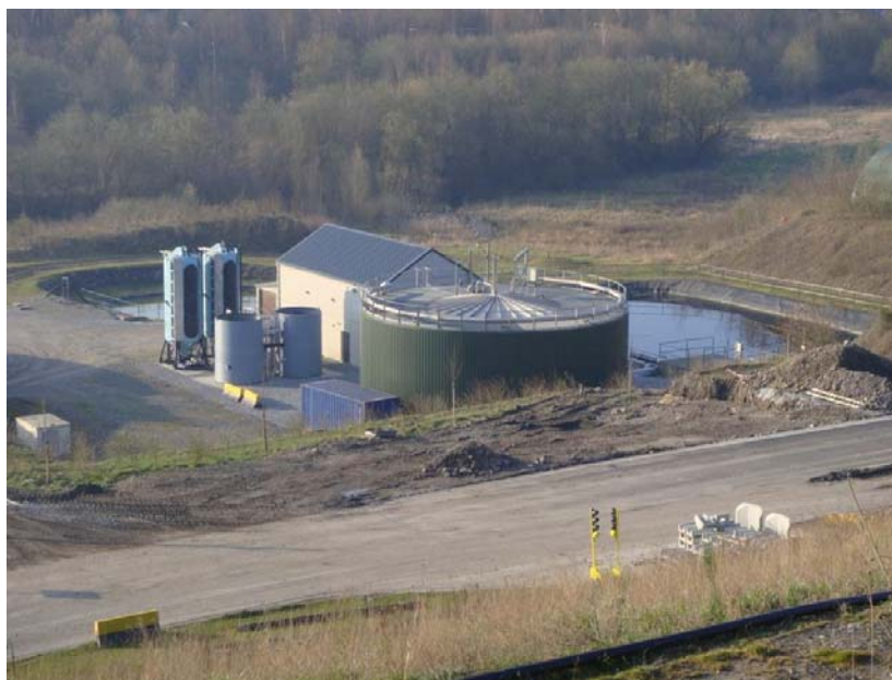
Figure 3: Vue de la STEP
