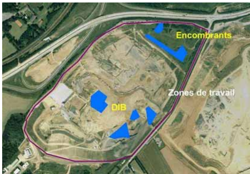
Figure 9 : Différentes zones exploitées durant la campagne de mesures de nuisances olfactives (source : rapport ULg- cfr. Annexe 7)
