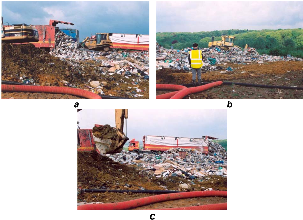
Figure 5 : Déversement (a), étalement (b) et recouvrement (c) des déchets.
