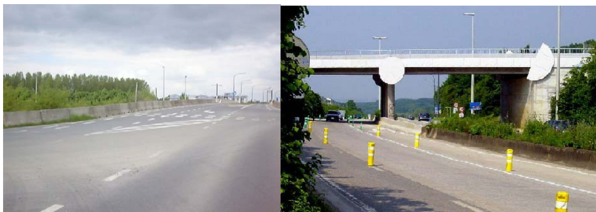
Figure 2 : Deux vues du nouveau pont des Trois Burettes
