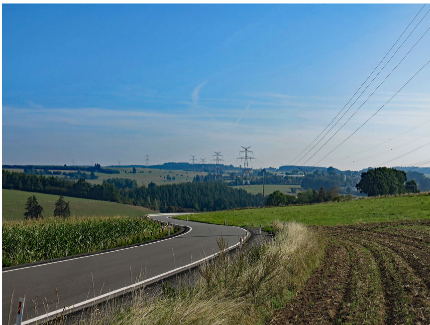
Vue sur la ligne haute tension depuis Taverneux vers le plateau de Gouvvy.
