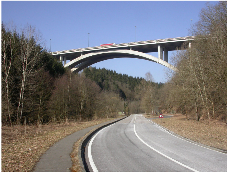
Viaduc de l'autoroute E25 à l'entrée Sud de Houffalize.
