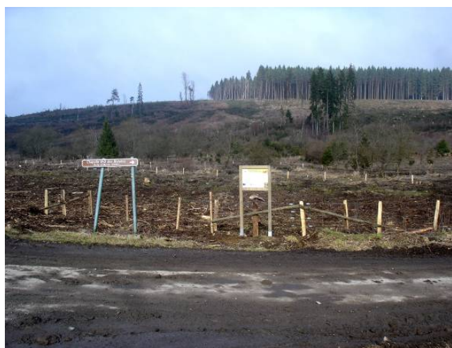
Placement de clôtures (1985 mètres) et d'un panneau signalétique.
