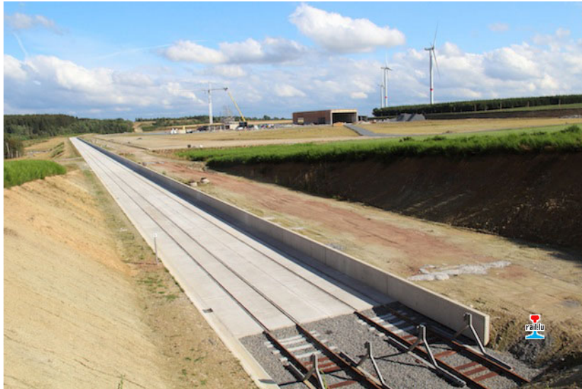
Travaux achevés au raccordement du Pôle Bois de Gouvy
